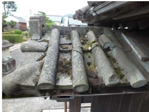
写真8 妻掛瓦2 正覚寺山門（控柱屋根隅瓦）
