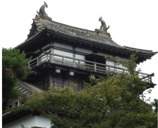
写真 3-4 丸岡城天守屋根
