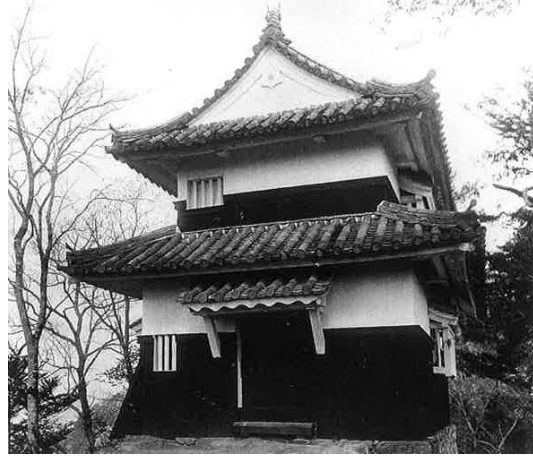
写真 3-2 備中松山城二重櫓 (国宝・重要文化財大全より)
