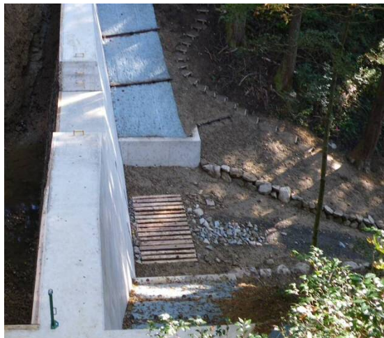
木製沈床工施工例
