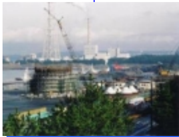
セメント会社によるサイロ建設中(平成 13 年)
