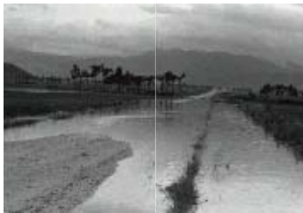
三味線川水田冠水 【昭和 47 年 7 月 11 日 台風 9 号】
