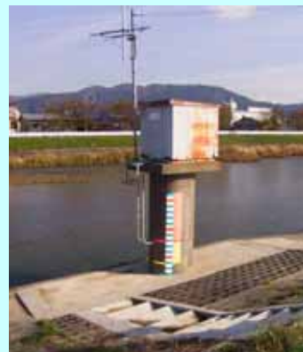
呉竹水位観測所 笹の川河口より約0.9km
