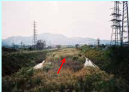
木の芽川河道内の植生 笹の川との合流点より約1.7km
