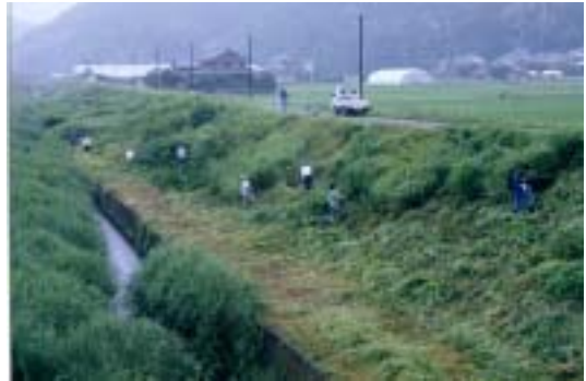
堤防の除草作業のようす (万願寺橋下流)
