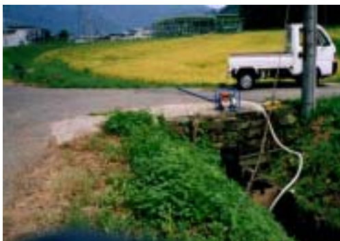
湧水対策ポンプ使用状況 （山田区、H8.7）
