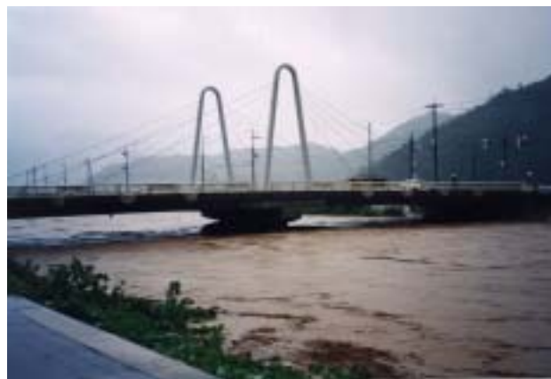
出水状況 (平成10年9月22日、大飯橋)
