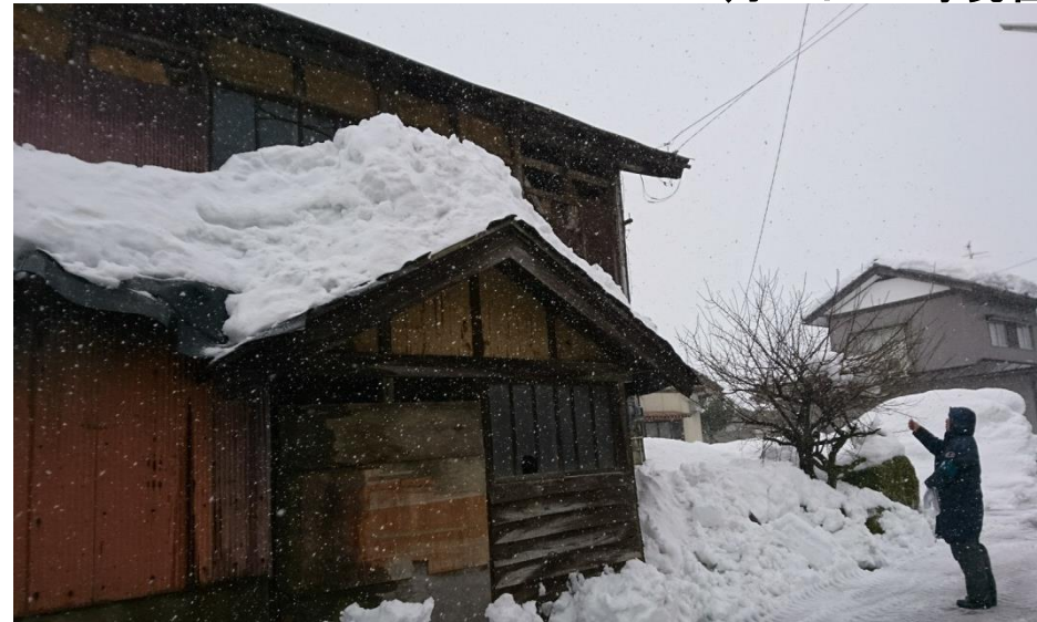
勝山市北郷町坂東島(不在家屋の危険個所の目視点検)
